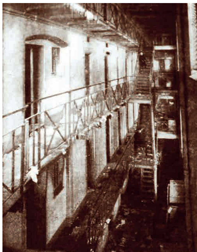
I en korridor.
